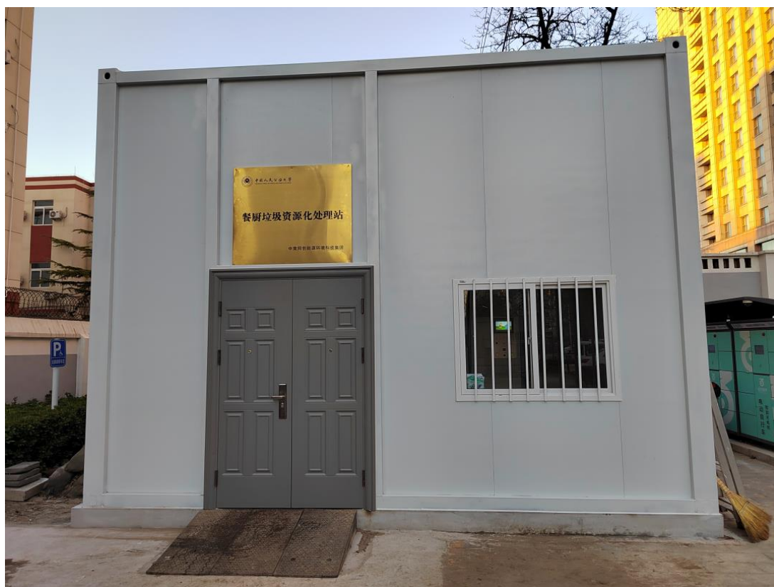
图5-1 木樨地校区厨余垃圾就地处理站外观（1台设备）
