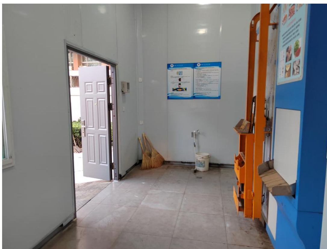
图5-2 木樨地校区厨余垃圾就地处理站内部（1台设备）
